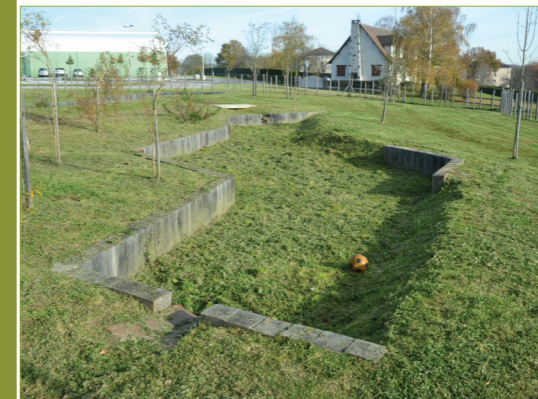
Bassin de rétention et d'infiltration des eaux pluviales, ALSH, Aix-sur-Vienne (87)
