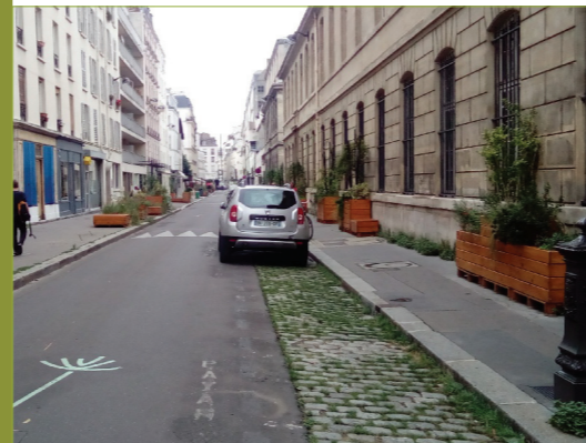
Pavés avec joints enherbés, Rue de Citeaux, Paris (12)
