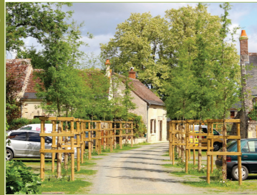
Aire de stationnement enherbée sous un double alignement d'arbres et allée en grave calcaire compactée, La Chapelle-aux-Naux (37)
